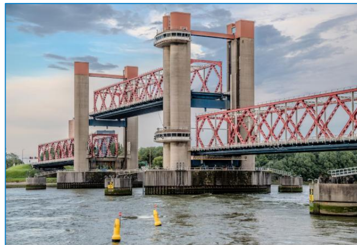
▲ De werkzaamheden aan de Spijkenisserbrug zijn eerder klaar dan gepland. © Gemeente Nissewaard
