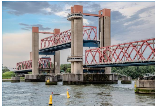
▲ De werkzaamheden aan de Spijkenisserbrug zijn eerder klaar dan gepland. © Gemeente Nissewaard
